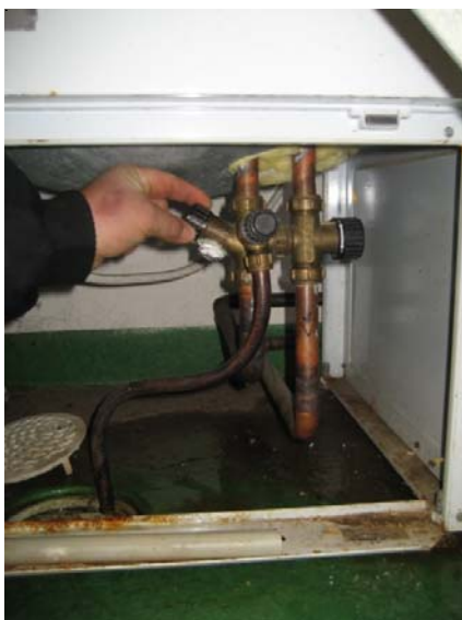
Fig. 8 Varmvattenberedare i herrarnas omklädningsrum Öppna pluggen och skruva moturs på kranen enligt bilden
