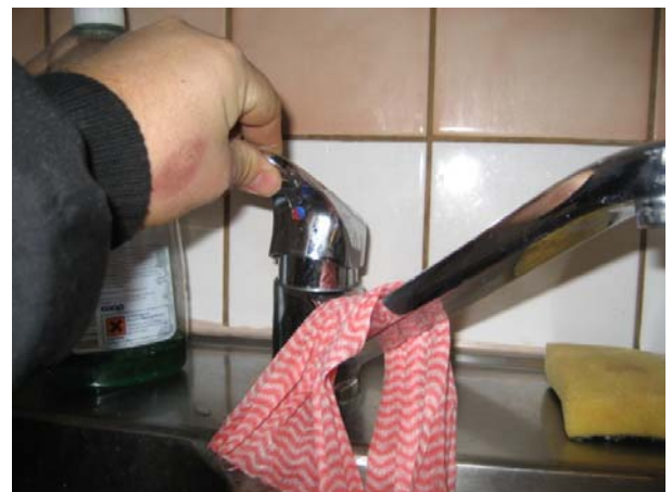
Fig. 5 Dränering av blandare i kök (Tranan) Fullt öppen i mittenläge (både varmt och kallt)
