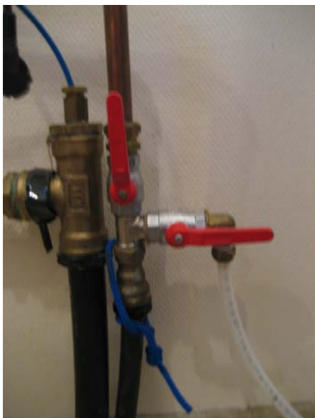
Fig. 6 Dränageslang monteras i herrarnas toaletterum
