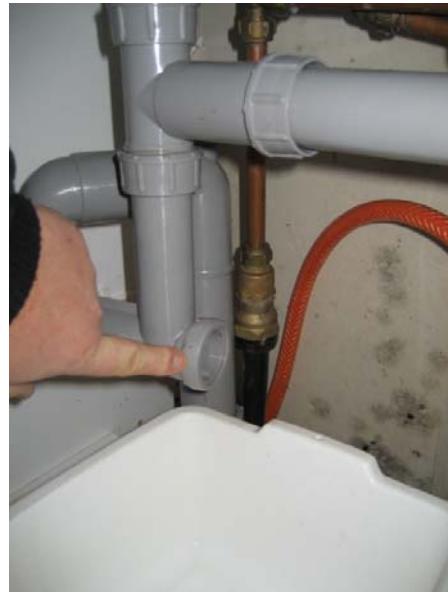
Fig. 13 Dränering vattenlås under diskho i köket.
