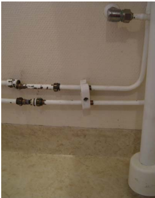
Fig. 4 Vattenledningar till handfat på båda toaletterna Dela ledningarna helt med en skiftnyckel. Anm. Fånga upp vattnet med en behållare.
