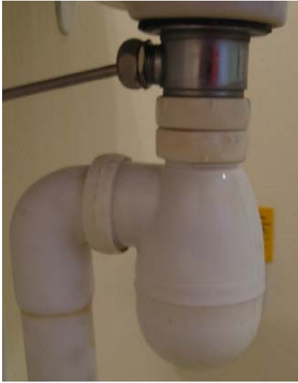
Fig. 10 Vattenlåsen på båda handfaten dräneras. Understa koppen skruvas bort.
